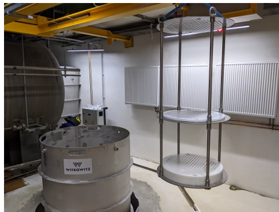
Obrázek 2: Přesun vnitřní vestavby do reaktorové nádoby
